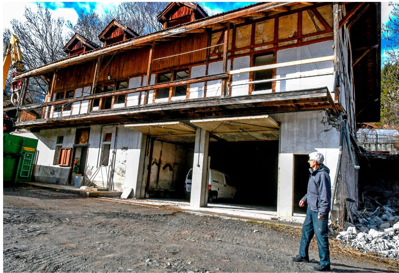
Paul Boss vor dem «Julianihaus» beim Bahnhof Frutigen: Es wird in Kürze abgerissen, um der Freilichttribüne Raum zu geben.
