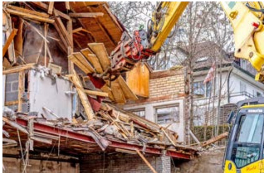
Der Bagger zerteilt das Haus sorgfältig, Stück für Stück.
