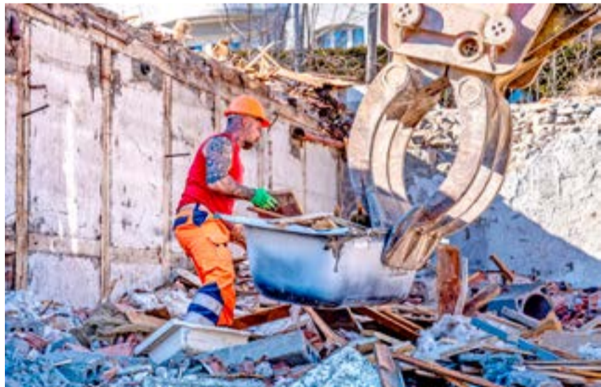
Filip sammelt Material zusammen, das beim Abriss auseinanderfiel.
